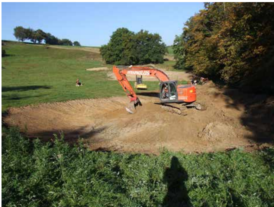
Abb. 70: Gewässerneuanlage im Bereich des "Bicherhaff". Foto: R. Proess.
